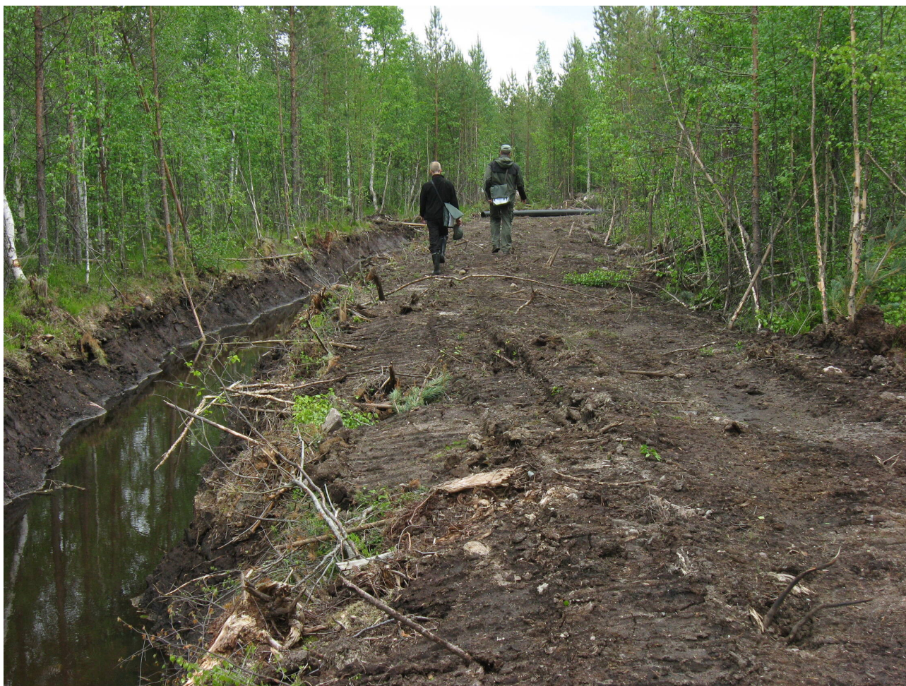
Ojamaat on läjitetty ja tasoitettu piennartieksi. Kuva: © Kalle Vanhatalo.
