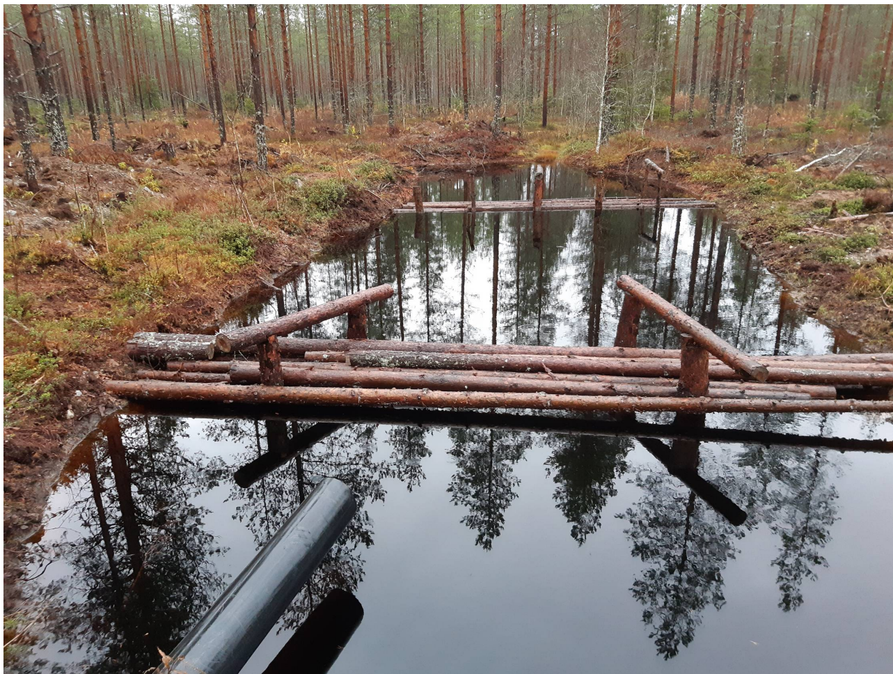
Karsittua rankaa aseteltuna laskeutusaltaaseen. Altaan pohjaan on juntattu paalut. Kuva: © Esko Keskinen.
