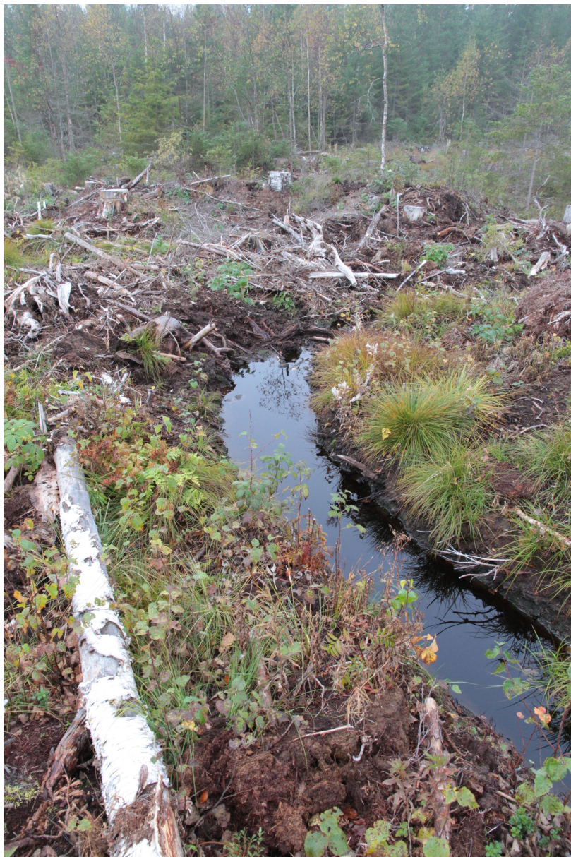
Naveroihin jätetyt kaivukatkot ovat pintavalutuskenttiä pienoiskoossa. Kuva: © Pentti Väisänen.
