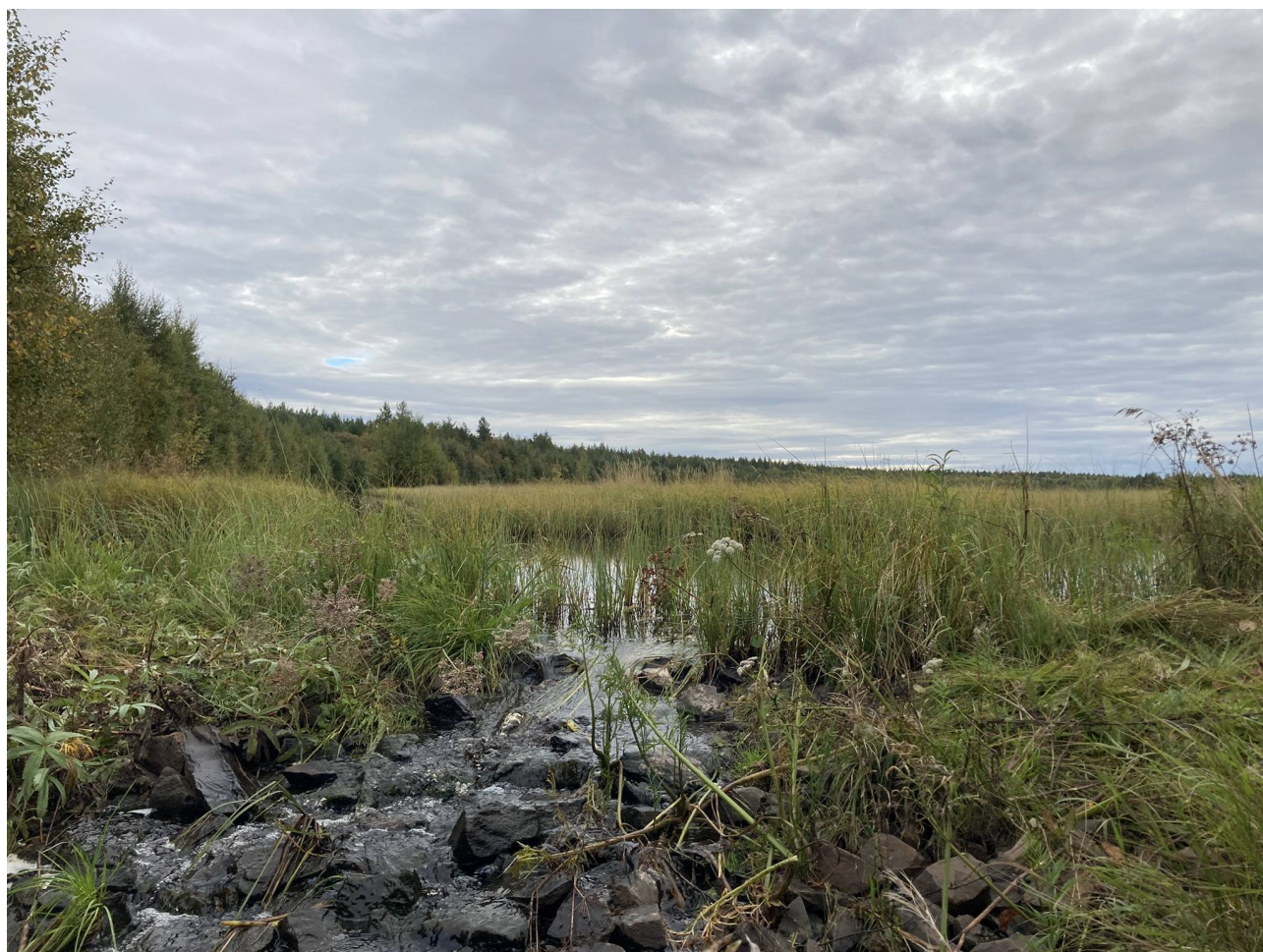
Kosteikon alapuolelle rakennettu pohjapato. Kuva: © Tiina Ronkainen.
