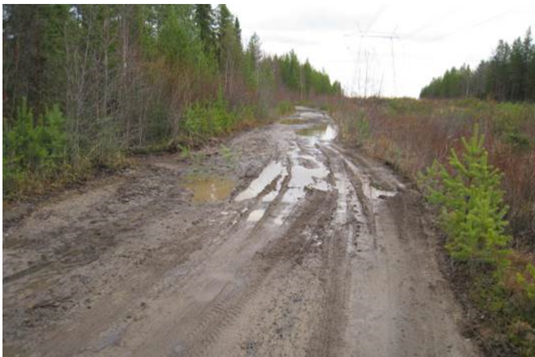
Runkokelirikkoa metsätiellä. Kuva: © Martti Perälä.
