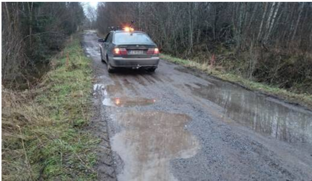
Reunapalteet estävät veden valumisen ojiin. Kuva: © Pekka Tahkola.
