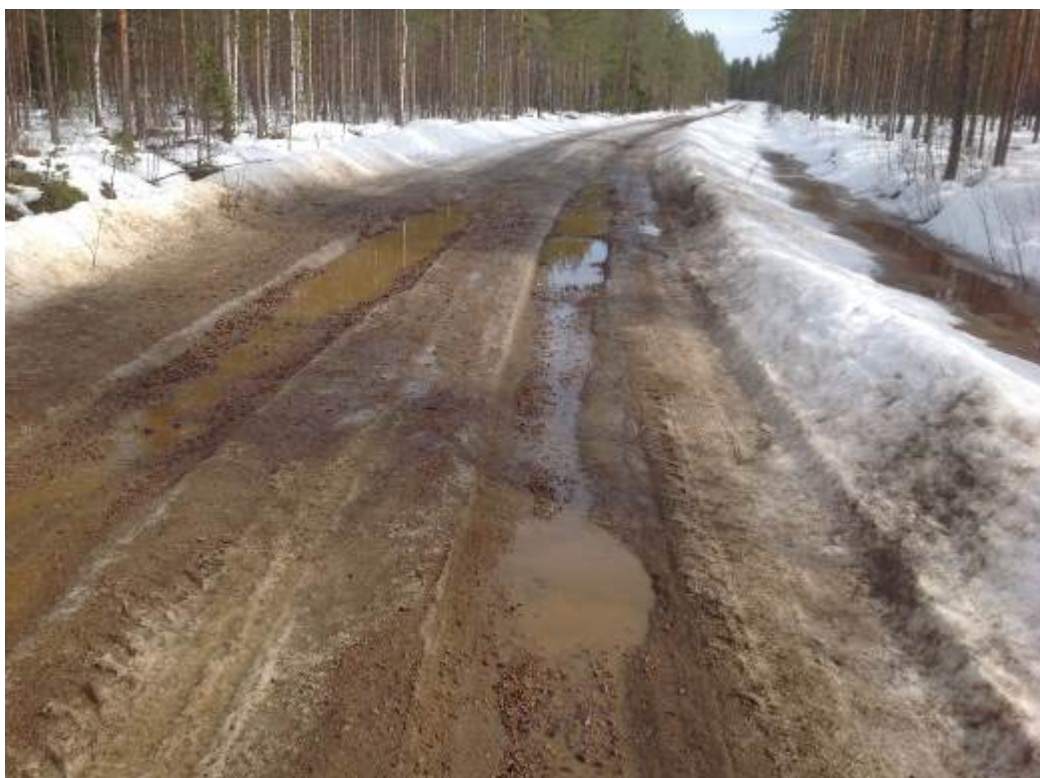
Sulamisvesien poisjohtamisesta ei ole huolehdittu. Kuva: © Martti Perälä.
