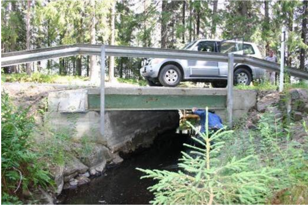
Silmämääräinen tarkastus kertoo nopeasti sillan yleiskunnosta. Kuva: Ilppo Greis.
