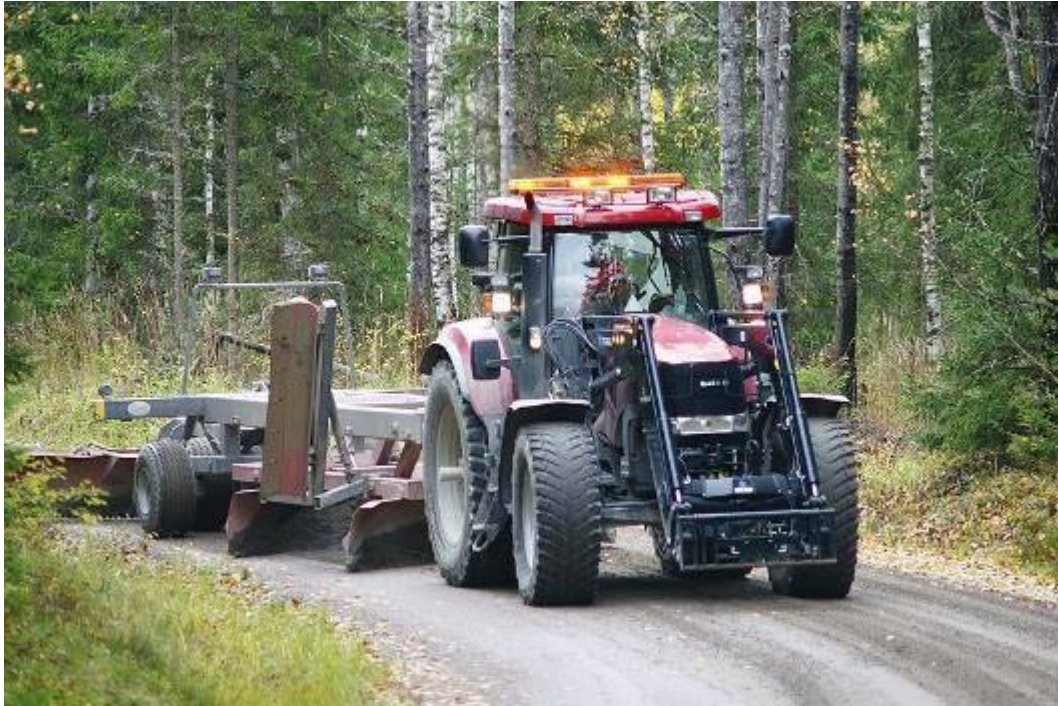
Metsätien lanausta järeällä kalustolla, lisäsiipi on pystyasennossa. Kuva: Navico Oy.
