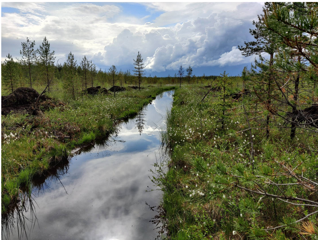
Avledningsdike som leder in vatten på en torvmark. Bild: © Maija Kauppila.
