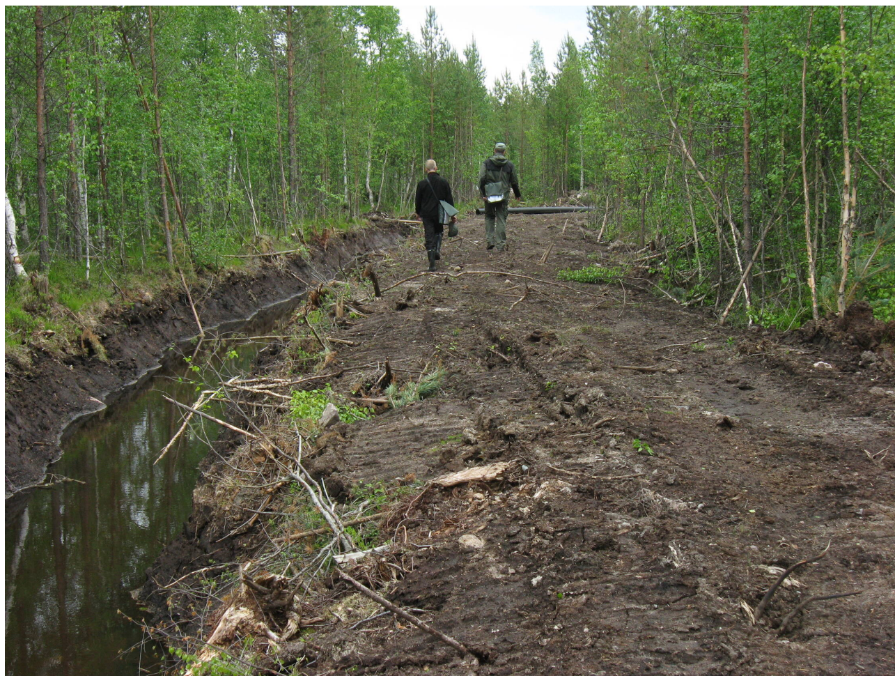
Dikesmassorna har brets ut och bildar botten till en väg på dikesren. Bild: © Kalle Vanhatalo.
