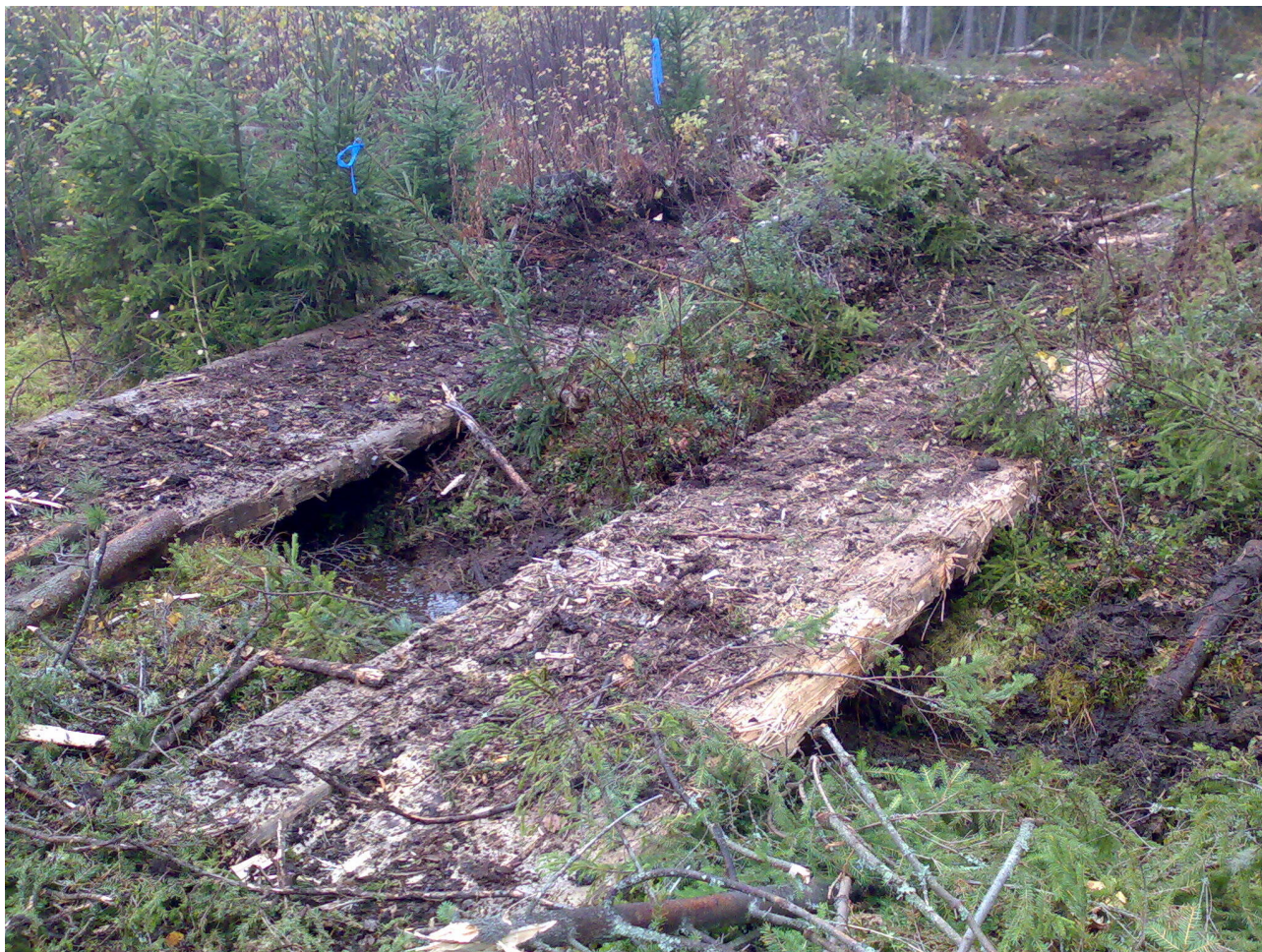
Körbroar av virke kan användas också för dikesövergångar. Bild: © Pasi Arkko.
