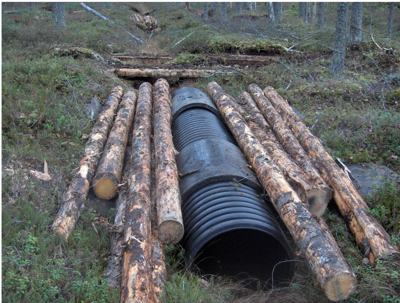
En tillfällig bro som anlagts för överfart över ett dike. Trumman har förstärkts och fästs på plats med hjälp av gumminattor. Bild: © Kati Kontinen.
