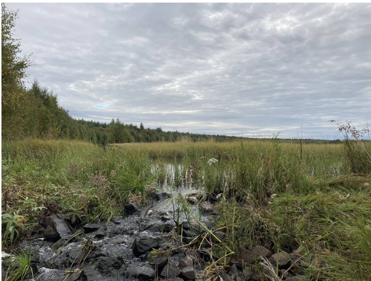
En bottendamm vid utloppet från en våtmark. Bild: © Tiina Törmänen.
