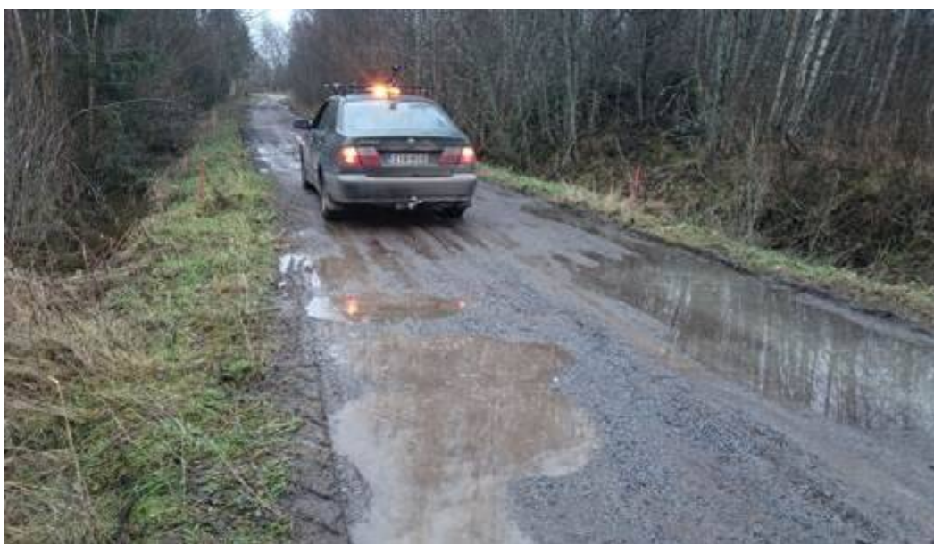
Kantvallarna hindrar vattnet att rinna ned i vägdiket. Bild: © Pekka Tahkola.
