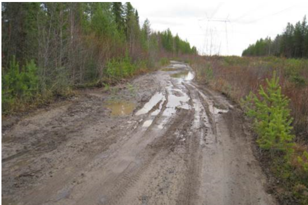
Djupa tjälskador på en skogsbilväg. Bild: © Martti Perälä.
