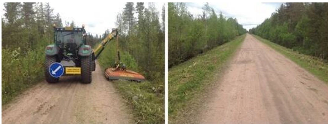
Slyröjning med en slykross. Bild: © Martti Perälä.
